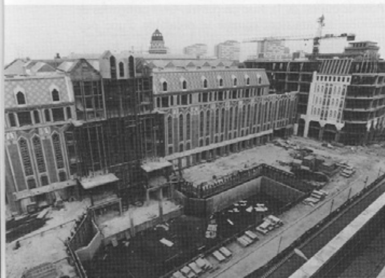
Berlin. Type de constructions réalisées actuellement (Bofill).
